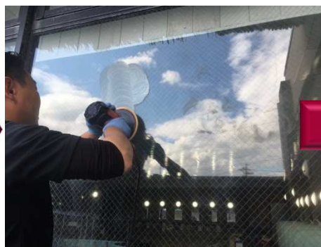
専用薬剤と機械を使用して除去します
