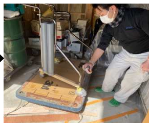
②ステンレスに塗料が密着しないのでプライマー塗布
